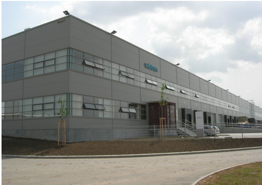
■ 捷克廠導入能效更高的生態化供熱系統以提供暖氣案例 捷克廠在 2012 年進行建築物的供熱系統及熱水供應的優化改善；由熱蒸汽供應廠將熱蒸汽輸送到廠區，同時透過供熱系統將熱蒸汽轉換成熱水。在 2012/ 2013 年的冬天，透過連接到的供熱系統，以更生態化的能源提供暖氣供應。
