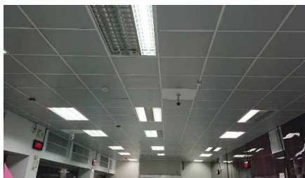
新竹廠 | 噪音防制工程
