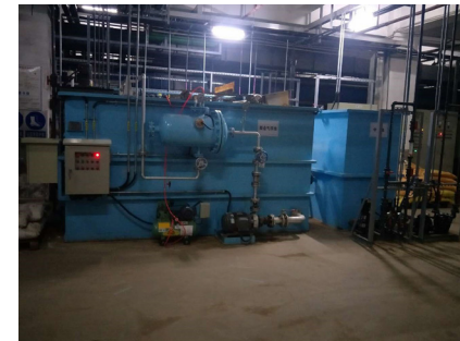
● 昆山光電廠 - 廢水站外觀
