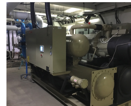
● 新竹廠 - 冰水主機汰換
