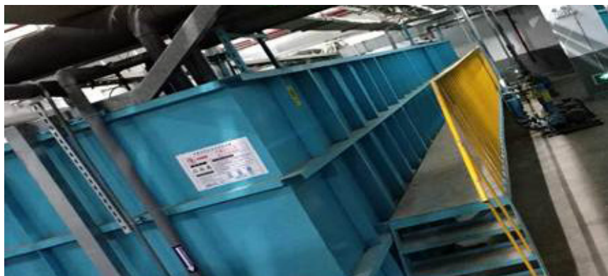
● 昆山光電廠 - 廢水處理站
