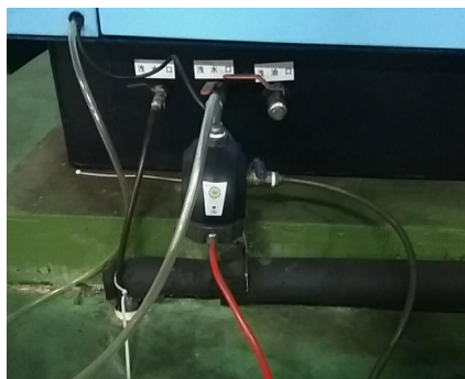
● 泰州廠 - 空壓機增設零損耗自動排水器節能
