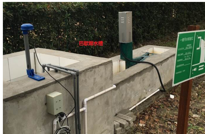
● 昆山光電廠 - 放流口 ( 巴黎雨水槽 )
