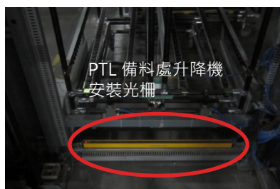
● 成都廠 - 產線升降機安全改造
