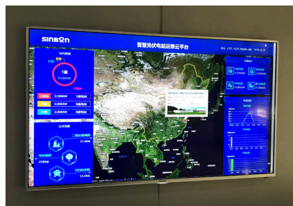
● 昆山廠 - 大廳設置太陽能發電資訊看板
