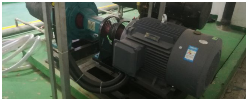
● 成都廠 - 更換高效節能泵
