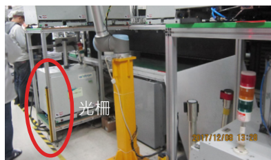
● 成都廠 - 機械手臂安裝光柵
